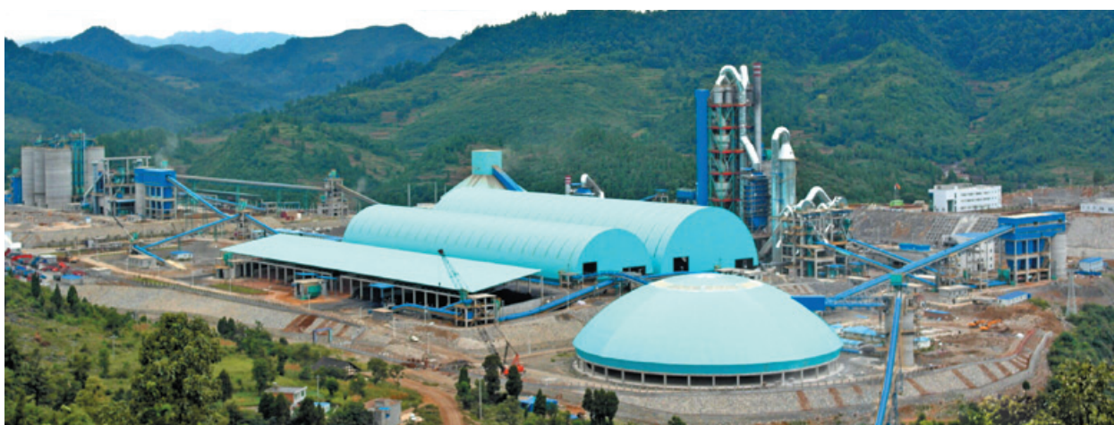
本公司位於貴州金沙縣的第一條日產5000噸新型乾法熟料生產線。 Our first 5000 tons per day NSP clinker production line in Jinsha County, Guizhou.
